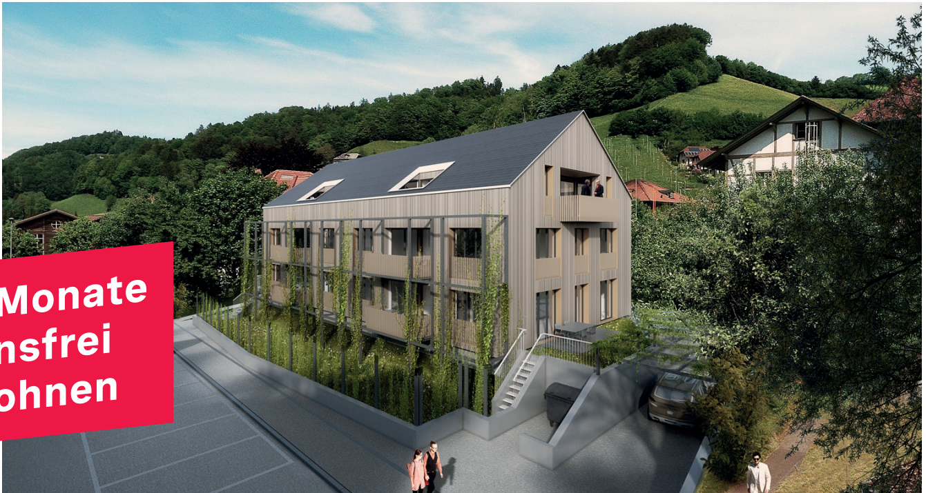
Wohnüberbauung Bärenmätteli, Walkringen (BE) www.jsimmo.ch
