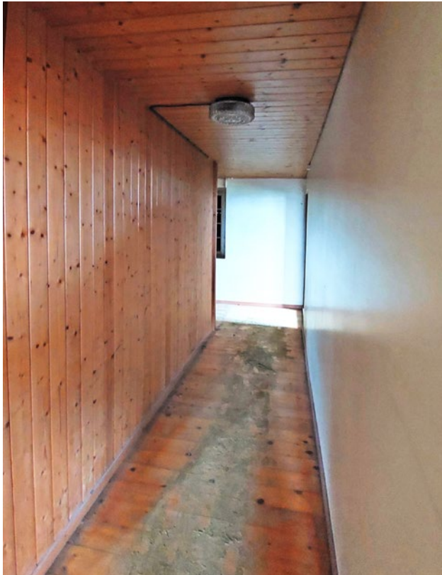
Wohnhaus • Obergeschoss: Gang, Boiler und Stauraum
