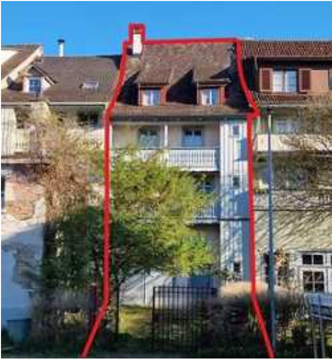
Ansicht des Gebäudes mit der privaten Zufahrt zur Garage
