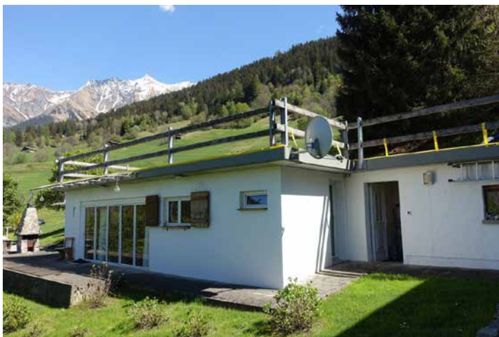
Die 2½-Zimmer-Wohnung mit grossem Gartensitzplatz und Gartenhäuschen
