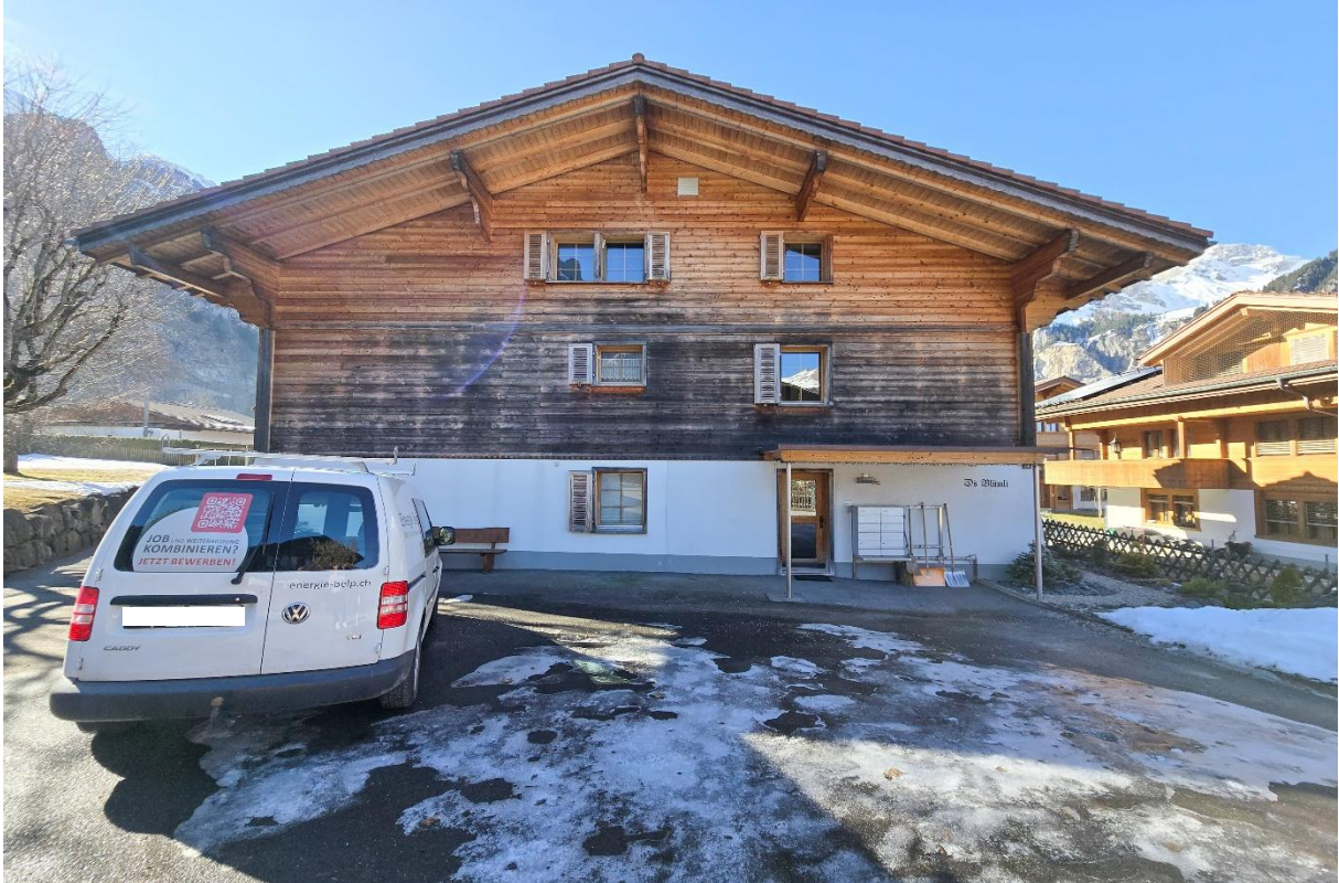
Die Aussenansichten des Mehrfamilienhauses
