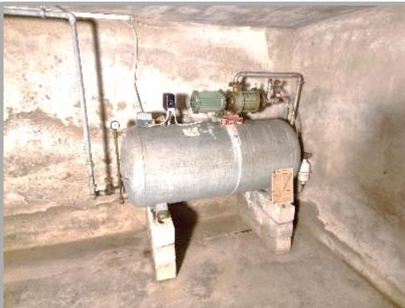
Eigene Grundwasser- pumpe für Wasserver- brauch Aussen
