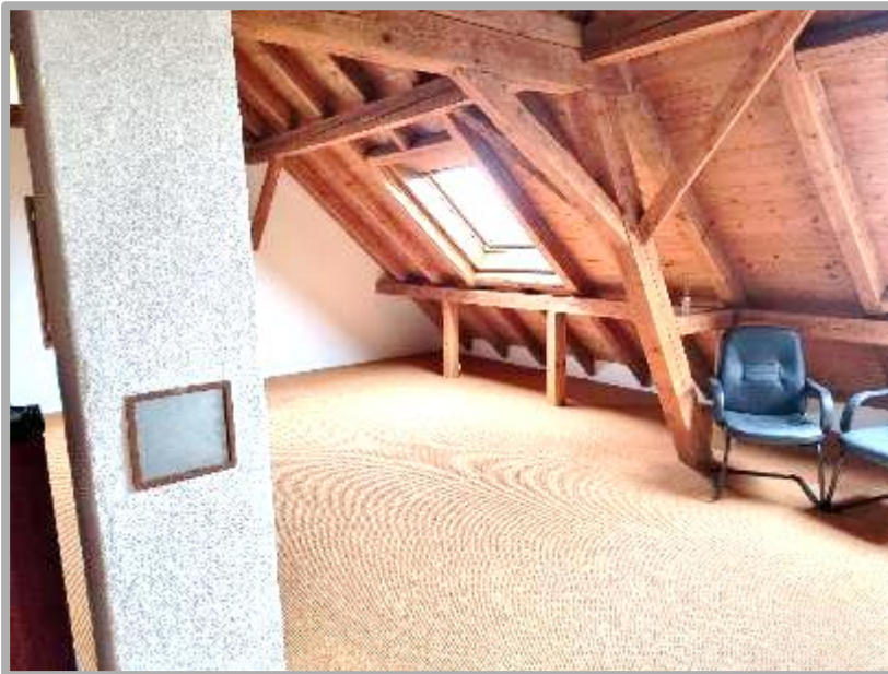
Grosser Raum DG Süd/Ostseite
