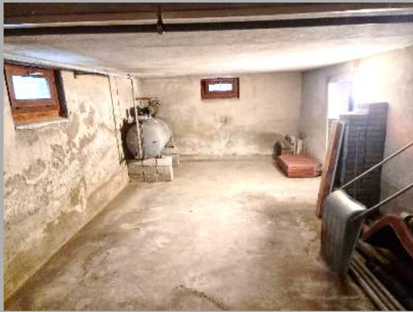
Kellerteil mit Betonboden
