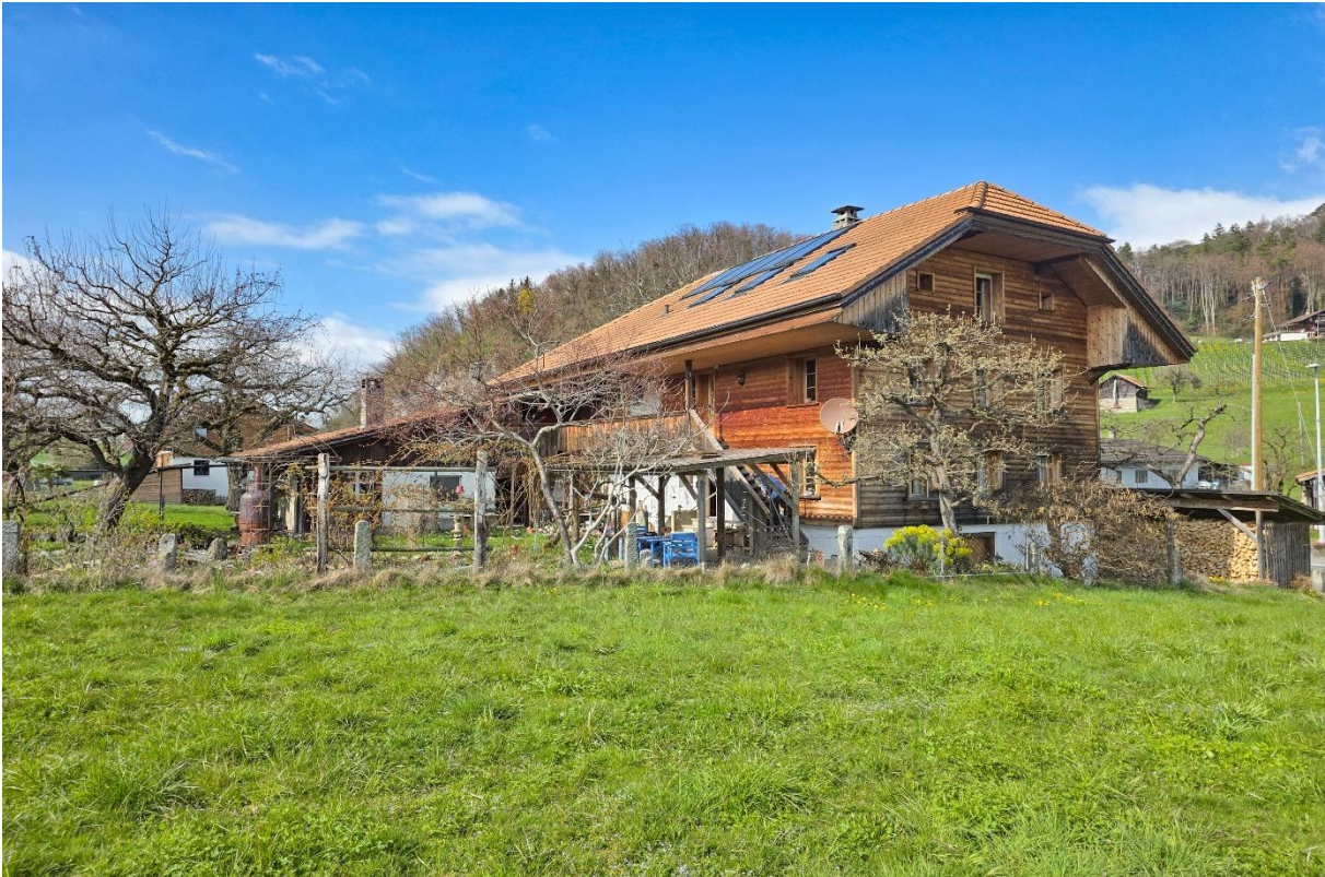
Die Aussenansichten des Wohnhauses...
